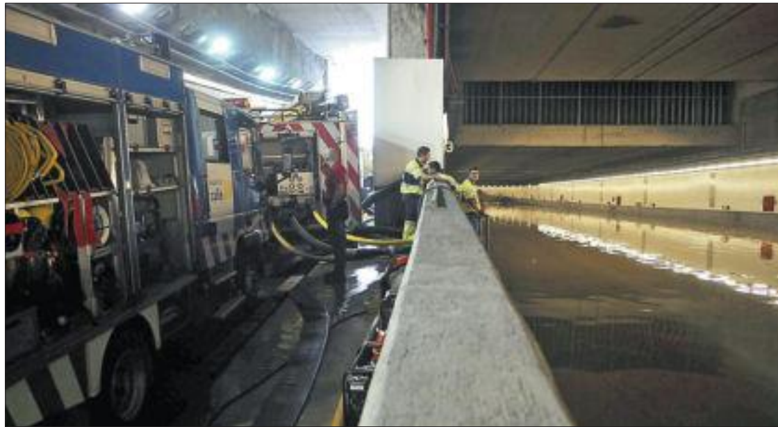
Operarios de la M-30 achicando el agua embalsada en los túneles el pasado 10 de septiembre. / JOSÉ RAMÓN AGUIRRE
