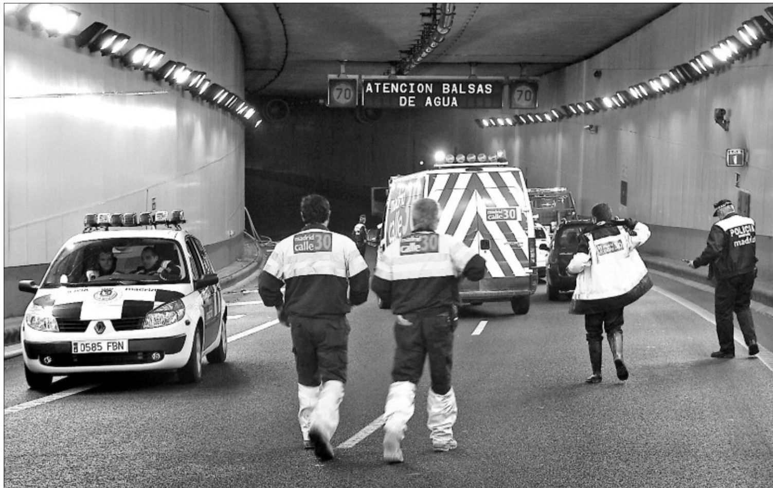
Túnel de conexión entre la M-30 y la A-3 cortado por las lluvias. / JOSÉ RAMÓN AGUIRRE
