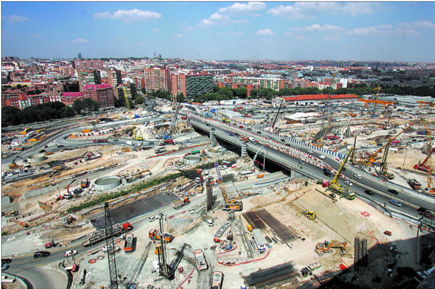
Vista panorámica de las obras de soterramiento de la M-30 a la altura del puente de Praga, en Madrid. / LUIS MAGÁN
