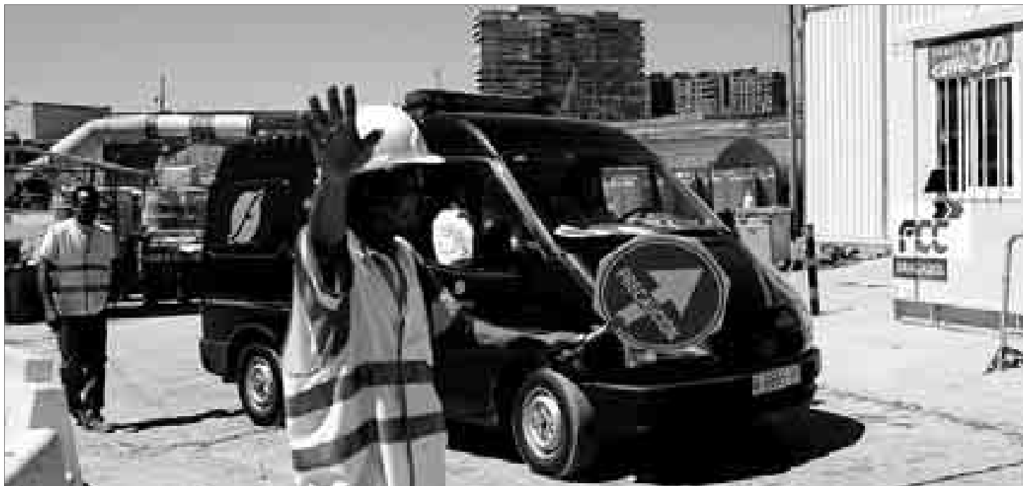
Un operario detiene el tráfico para que salga el furgón en el que se encuentra el cadáver del trabajador fallecido ayer en las obras de la M-30. / ANTONIO HEREDIA
