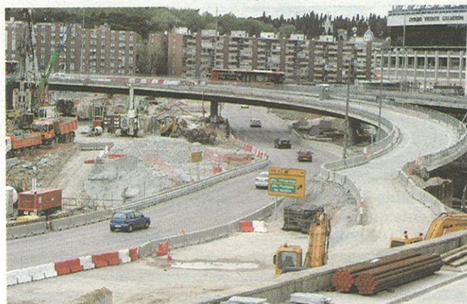
Se acabaron las obras en la mayor parte de la zona oeste de Madrid.
