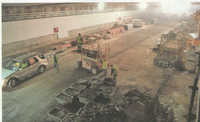
La construcción de los túneles ha supuesto un auténtico reto.
