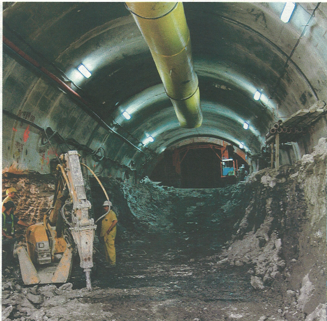
El proyecto afecta a un total de 16,6 kilómetros de viario, de los que 3,8 kilómetros corresponden a un túnel.
