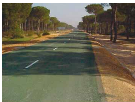
_ El acondicionamiento de la carretera HF-6248. Tramo: Intersección A-483 (Almonte) al PK. 1,200 de la HF-6245 (Los Cabezudos).
