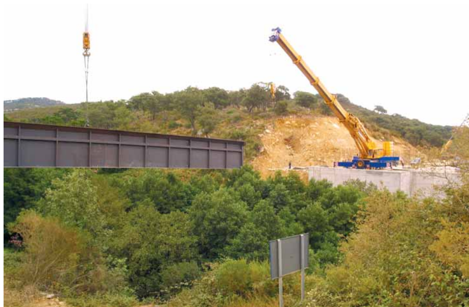
Construcción de viaducto sobre la Garganta de Juan Ramos, Autovía A-381.
