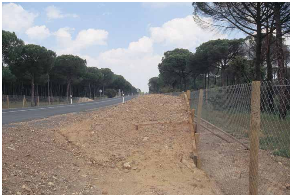
Vallado de cerramiento de paso de fauna con rampa de escape
